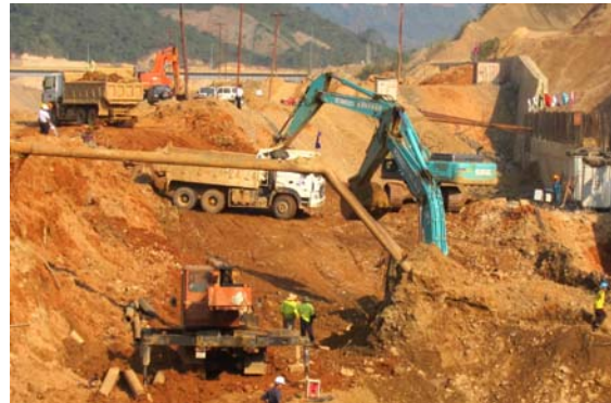
Trên công trường thi công NMTĐ Lai Châu
